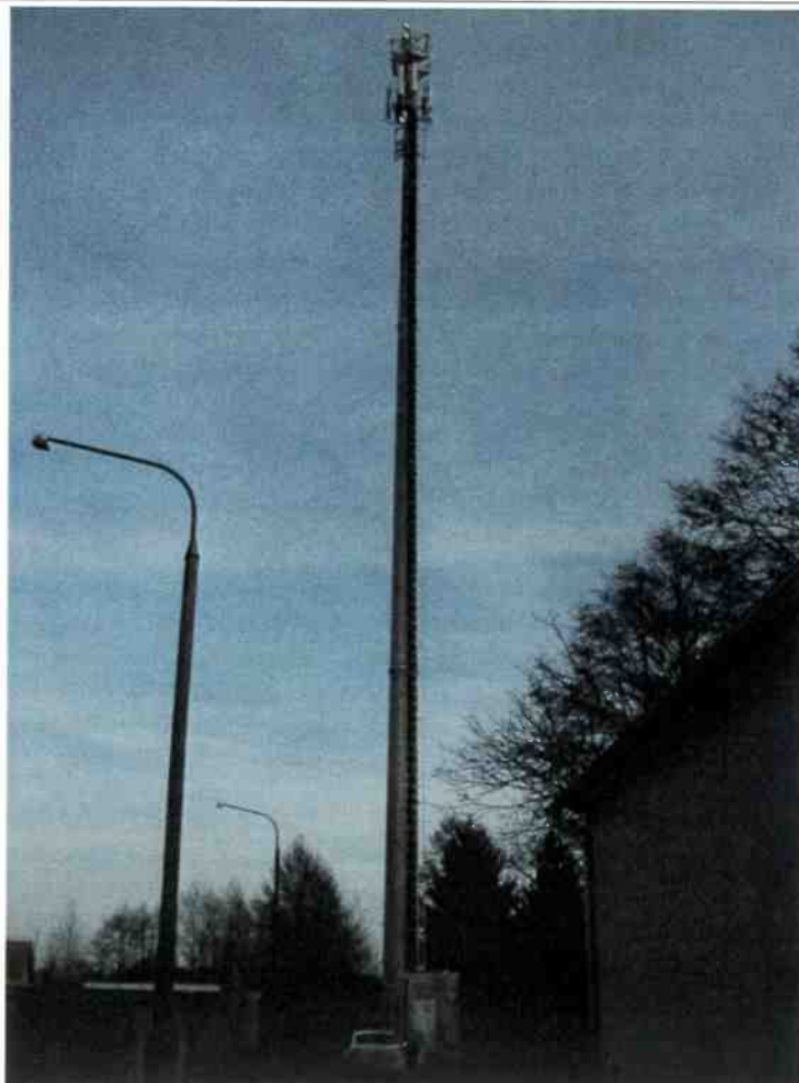
Zaf. nr 1: Widok ogólny instalacji radiokomunikacyjnej.
