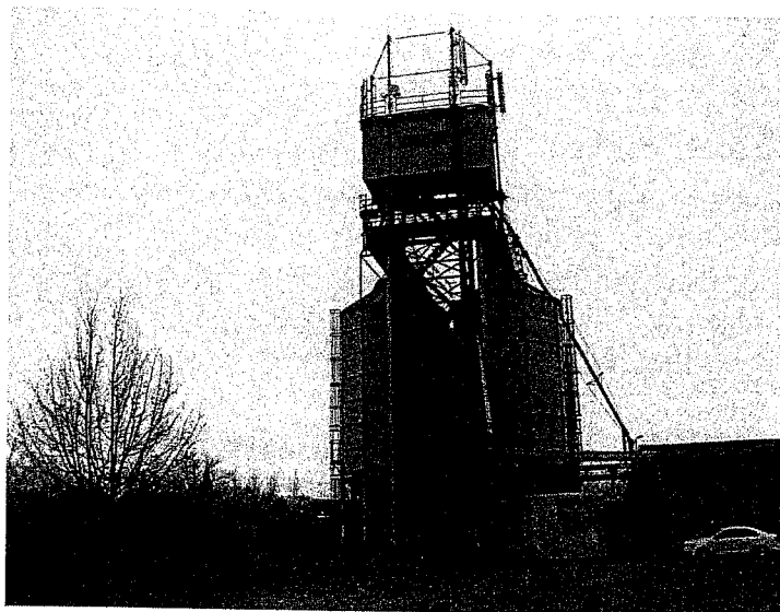
Zał. nr 1: Widok ogólny instalacji radiokomunikacyjnej.
