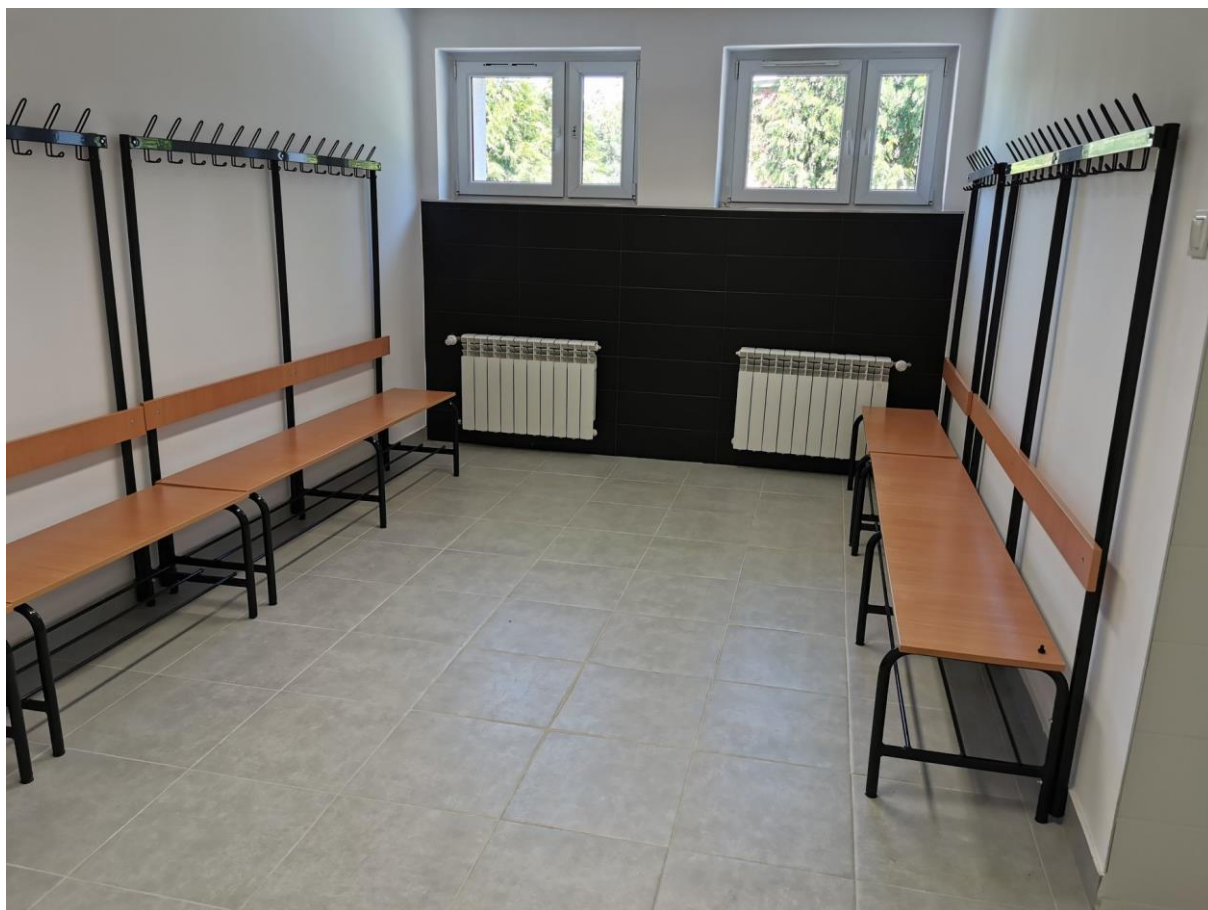
REMONT SZATNI W ZESPOLE SZKÓŁ NR 1 W NOWYM TOMYŚLU
