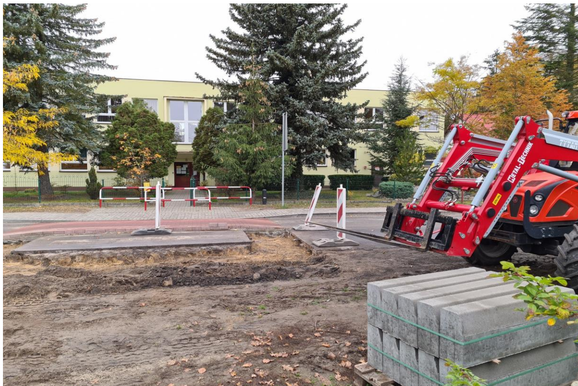
BUDOWA PODWYŻSZONEGO PRZEJŚCIA DLA PIESZYCH PRZY SZKOLE PODSTAWOWEJ W BORUI KOŚCIELNEJ
