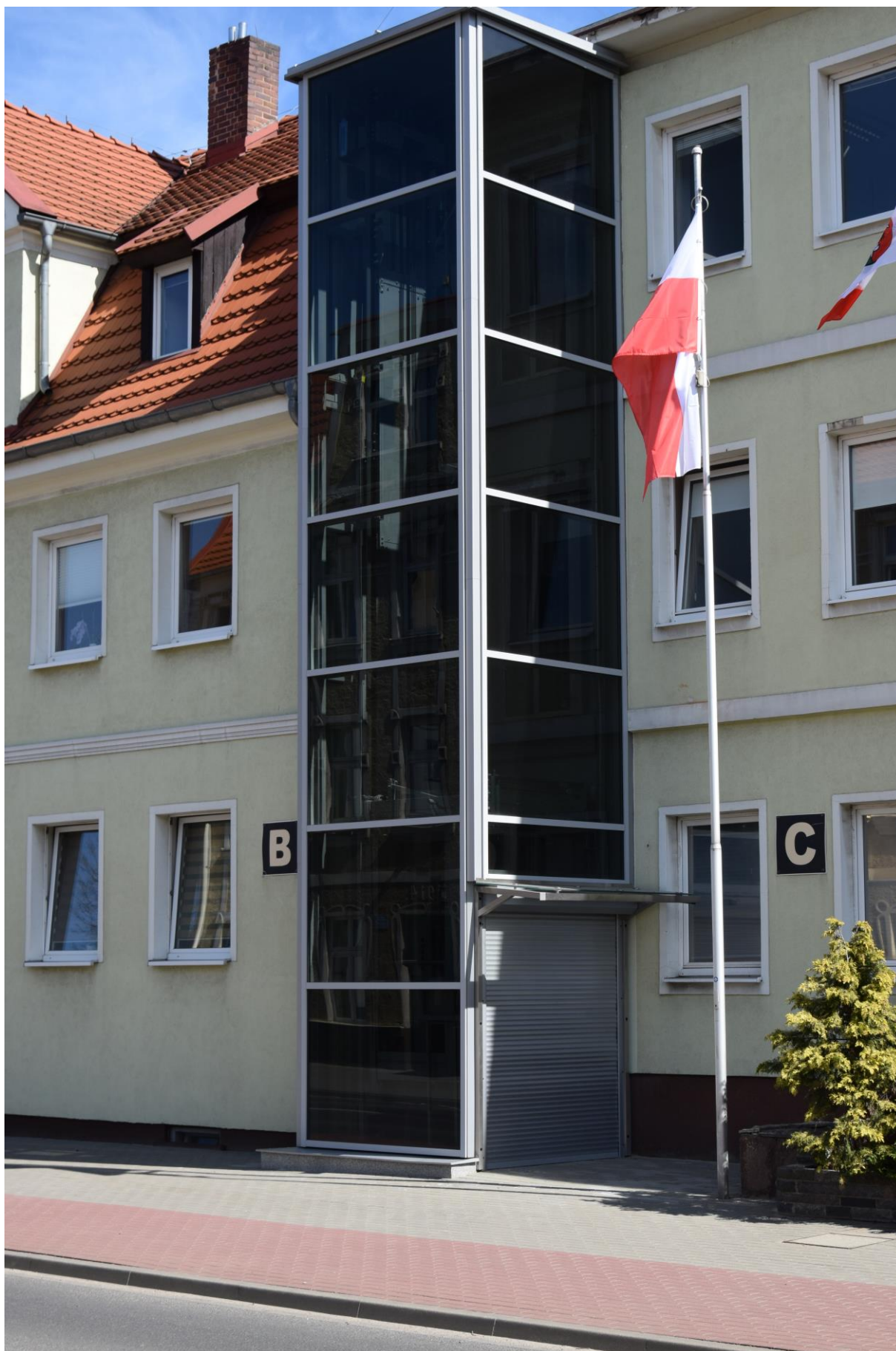
BUDOWA WINDY PRZY BUDYNKU STAROSTWA POWIATOWEGO W NOWYM TOMYŚLU
