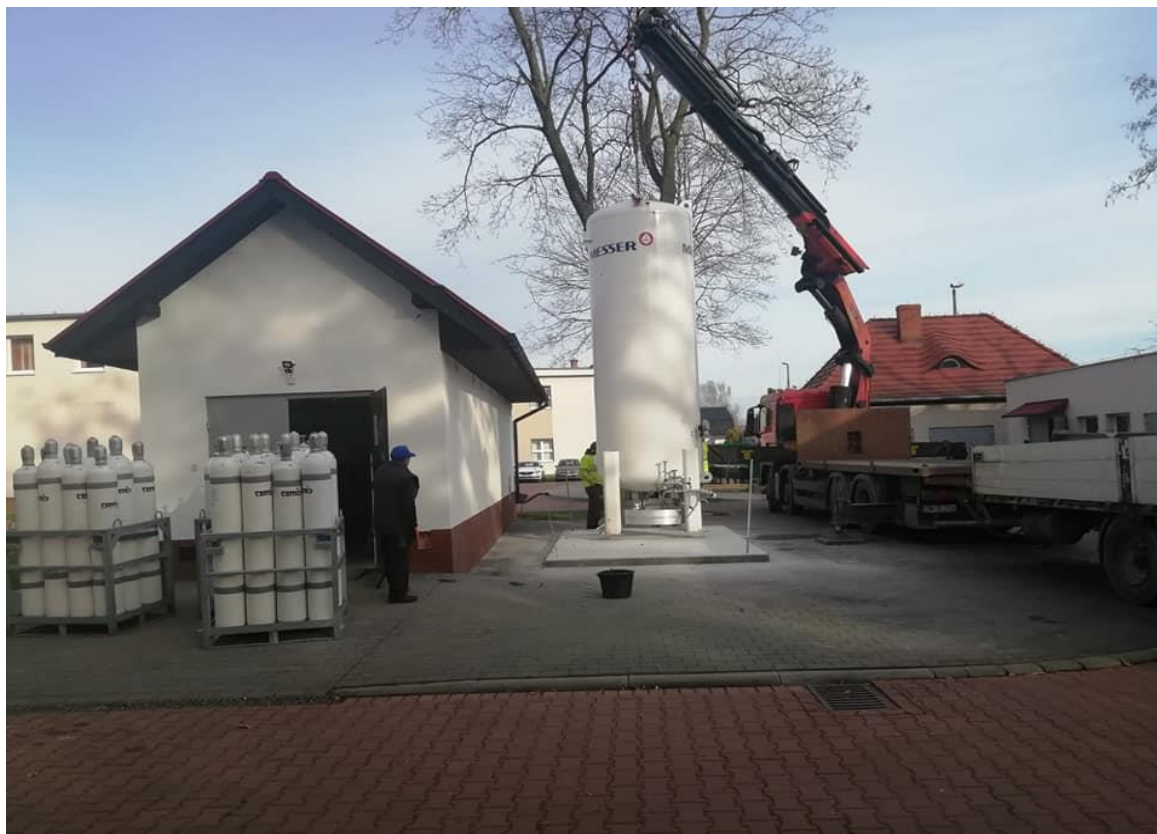
MONTAŻ ZBIORNIKA TLENU MEDYCZNEGO
