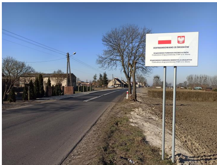
Przebudowa drogi powiatowej 2738P w m. Śliwno.
