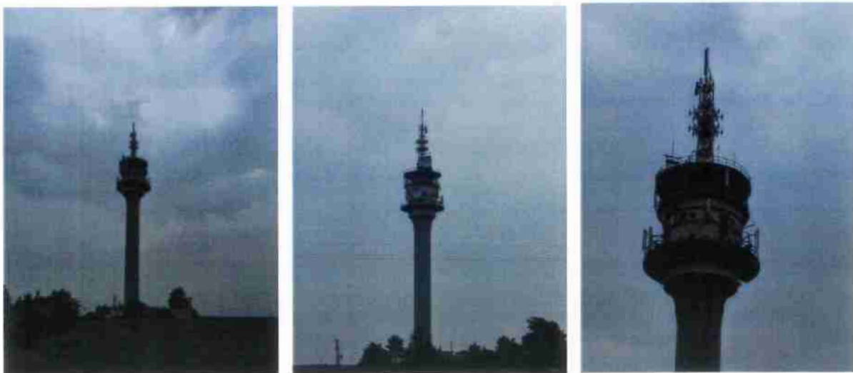
Widok obiektu wraz z zainstalowanym zespołem antenowym
